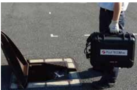
監視盤が設置できない場所でも※
