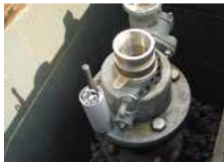
消火栓へのロガー設置
