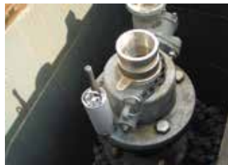
消火栓へのロガー設置
