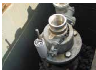
消火栓へのロガー設置
