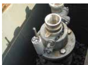
消火栓へのロガー設置
