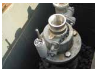
消火栓へのロガー設置
