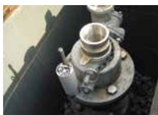
消火栓へのロガー設置
