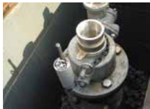
消火栓へのロガー設置
