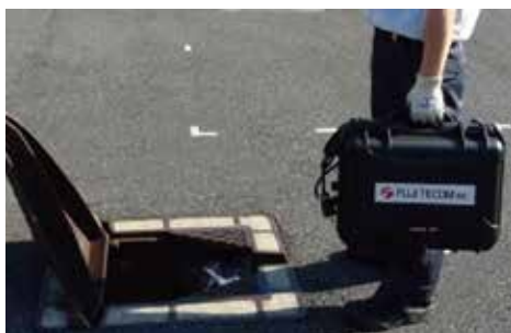
監視盤が設置できない場所でも※
