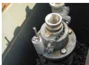
消火栓へのロガー設置
