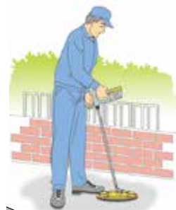
管路の探査例
